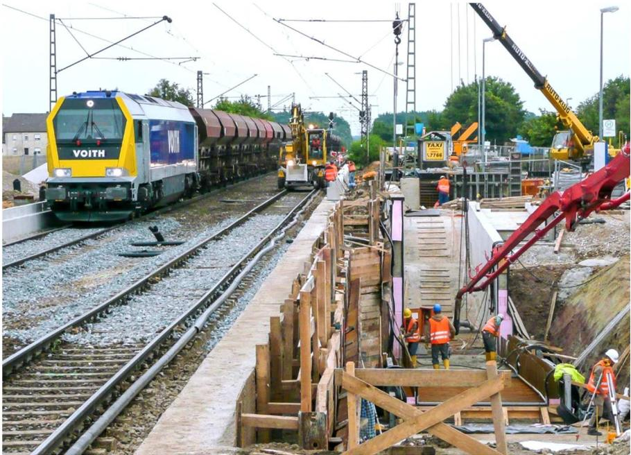
*In den Sommerferien 2010 wurden auf einigen Abschnitten der KBS 898 Schotter und Gleise komplett ausgetauscht. In Heilsbronn erweiterte DB Netz auch noch die Bahnsteigunterführung. Am 18.8.10 fuhr eine sechssachsige Voith Maxima 30 CC mit einem Schotterzug durch die Baustelle nach Westen.*
