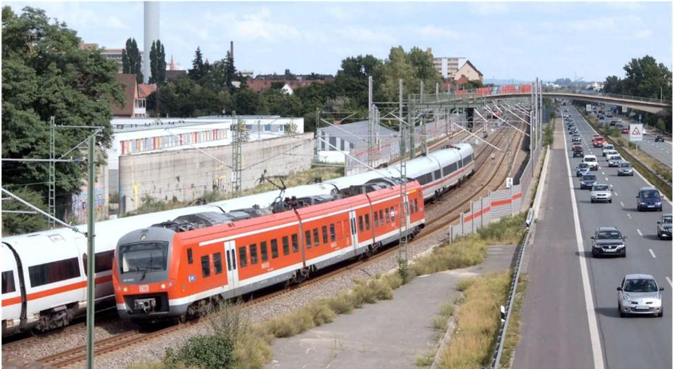
*Blick nach Osten auf die viergleisige Strecke an der Stadtgrenze Nürnberg/Fürth am 15.7.14: Nur das (größtenteils verdeckte) nördlichste Gleis dient der S-Bahn in beiden Richtungen im 20- bis 40-Min.-Takt. ICE, IC, RE und RB nutzen die anderen 3 Gleise. Bei **FIT** sähe dieser Bereich genau so aus, die Gleise würden aber paarweise von der Citybahn und den anderen Zügen genutzt und dadurch mehr Kapazität bieten.*
