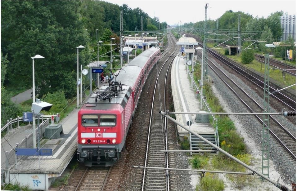
*In Eibach sieht man den Gigantismus, der beim Bau der S3 nach Roth betrieben wurde. Und das, obwohl 1996 schon feststand, dass der Fernverkehr nach München auf die Neubaustrecke entlang der Autobahn A9 abwandern würde: Links das neue S-Bahn-Gleispaar, in der Mitte die „Fernbahngleise“ und ganz rechts der Anschluss zum Nürnberger Hafen. (Blick nach Norden von Jörg Schäfer am 20.8.08)*
