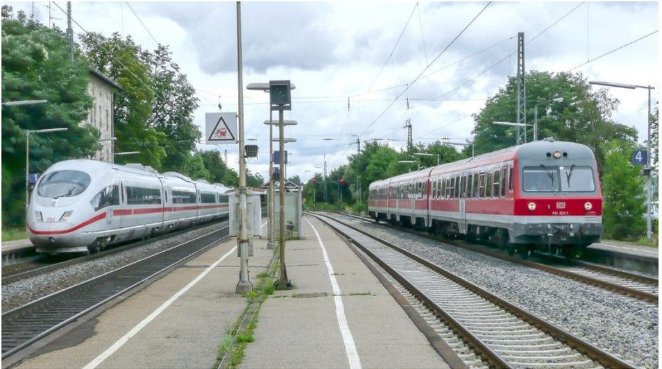
*Blick vom Bahnsteig in Siegelsdorf nach Osten: Der ICE fuhr ohne Halt durch Gleis 1 Richtung Würzburg, während 614 022 nach Markt Erlbach in Gleis 4 auf den Gegenzug wartete. Bei **FIT** wäre dieses Bild nicht möglich, weil es zwischen den Gleisen keinen Bahnsteig mehr gäbe: Alle RB halten an zwei Außenbahnsteigen, die RB nach Markt Erlbach unterqueren dann in einer neuen Unterführung das Gleispaar der Hauptstrecke nach Würzburg. (Jörg Schäfer, 4.8.2008)*
