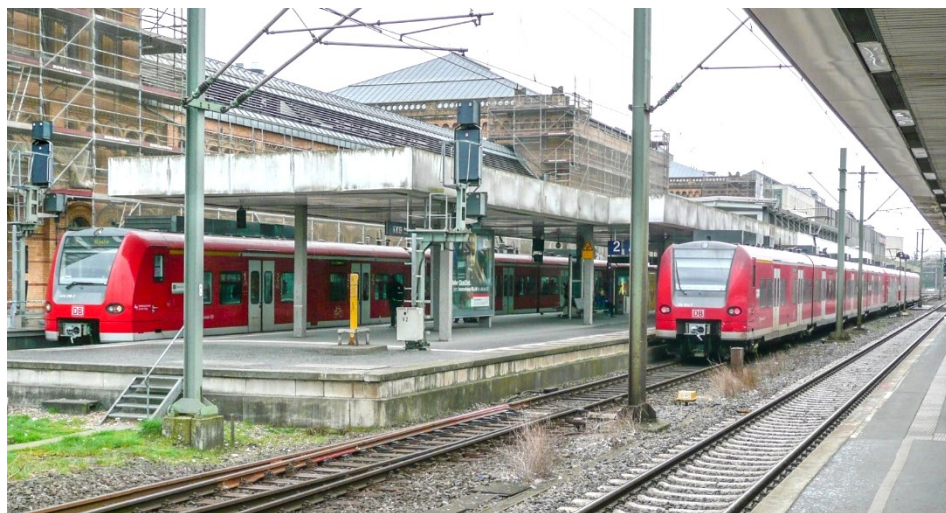
Blick nach Westen in Hannover Hbf am 29.3.17: Am S-Bahnsteig begegneten sich 424 010 auf Gleis 1 (links) und 424 034 auf Gleis 2.
